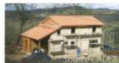
Auto-construction en paille, isolation liège
