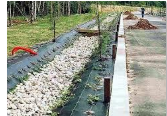
Noue plantée et filtrantes (sols imperméables)
