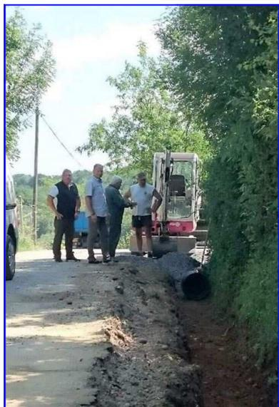
D'importants travaux de voirie ont été réalisés chemin de la Plano afin de traiter l'écoulement des eaux pluviales par le busage du fossé.
