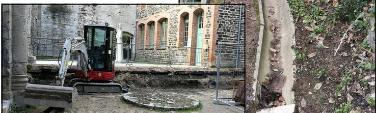
*Mise en place de demi-buses afin de canaliser les eaux pluviales*
