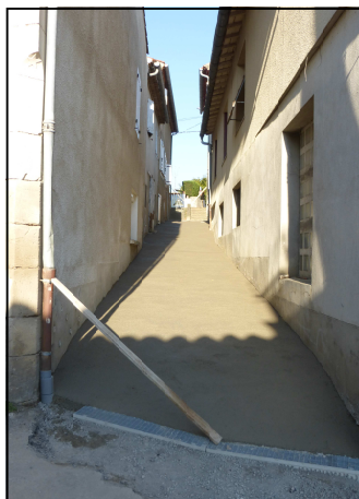
Réfection d'une ruelle de la Bracadelle en béton balayé.
