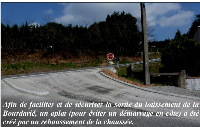
Afin de faciliter et de sécuriser la sortie du lotissement de la Bourdarié, un aplat (pour éviter un démarrage en côte) a été créé par un rehaussement de la chaussée.
