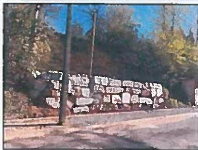
A Labourdarié, ce printemps, il a fallu stabiliser le talus en créant un enrochement avec des blocs de granit du Sidobre.
