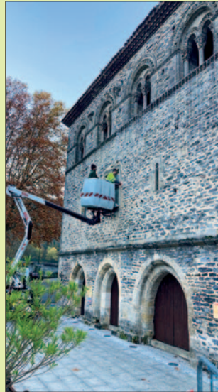
Intervention sur le pavillon Adélaïde
