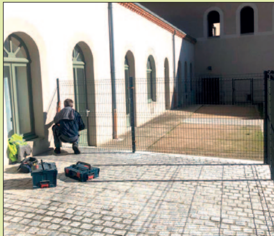
Espace loisirs square Arnaud de Mareuil : Terrassement avant de couler la dalle pour installer le jeu d'enfants - Pose de la clôture
