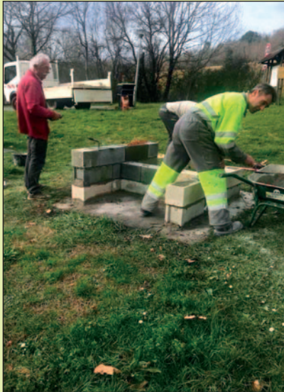
Construction d'un barbecue au Lézert
