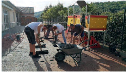
Mise en place des jeux extérieurs dans la cour des écoles.
