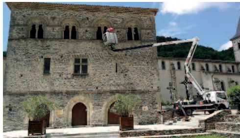
Nettoyage des vitres du pavillon d'Adélaïde.
