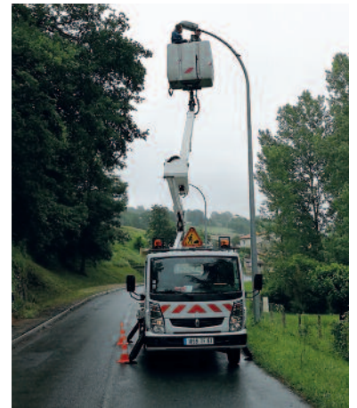
Remplacement des lampes de l'éclairage public par des leds.
