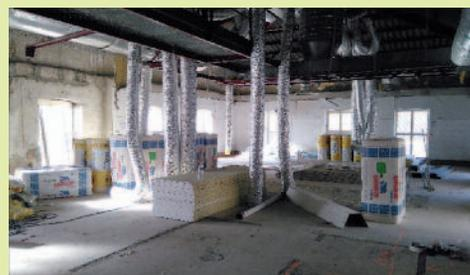
Préparation de l'installation de la climatisation et de l'intervention des plaquistes (doublage des murs, cloisons).
