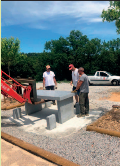
Installation d'une table de pique nique en granit à Lafontasse
