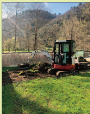
Création d'un espace de compostage au cimetière
