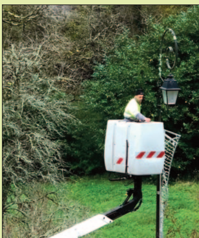
Pose des illuminations Noël
